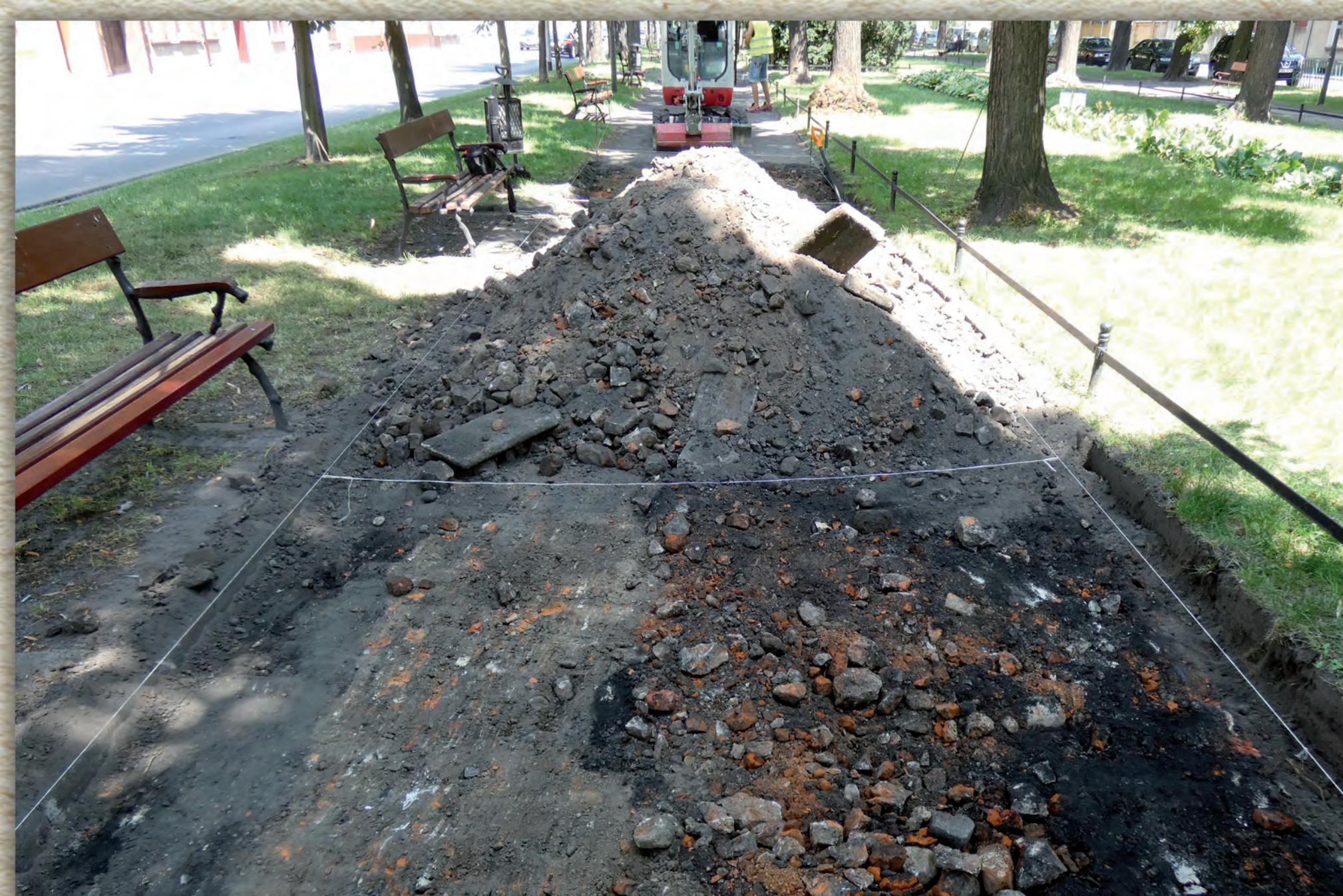
Fragmenty macew, cegieł oraz gruz budowlany - wymiana nawierzchni rawickich plant, 2018 r.
