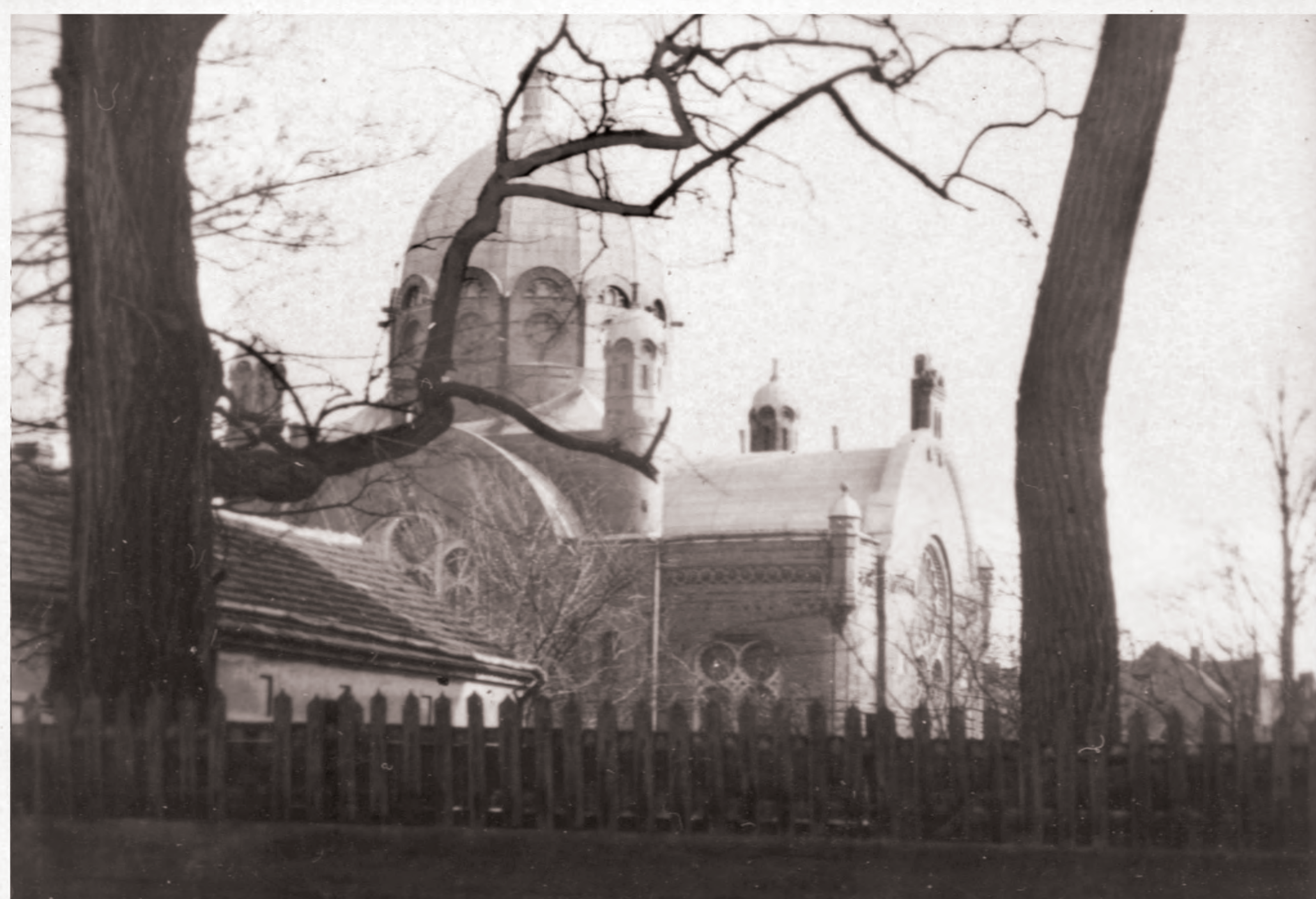
Fotografia przedstawiająca rawicką synagogę (1889-1941) prawdopodobnie w 1940 r. Widok od strony Posener Stadtgraben (obecnie Wały Jarosława Dąbrowskiego)
